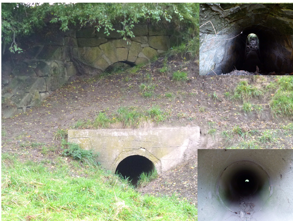
Obr. 14. Kombinace starého, klenutého a trubního propustku.
