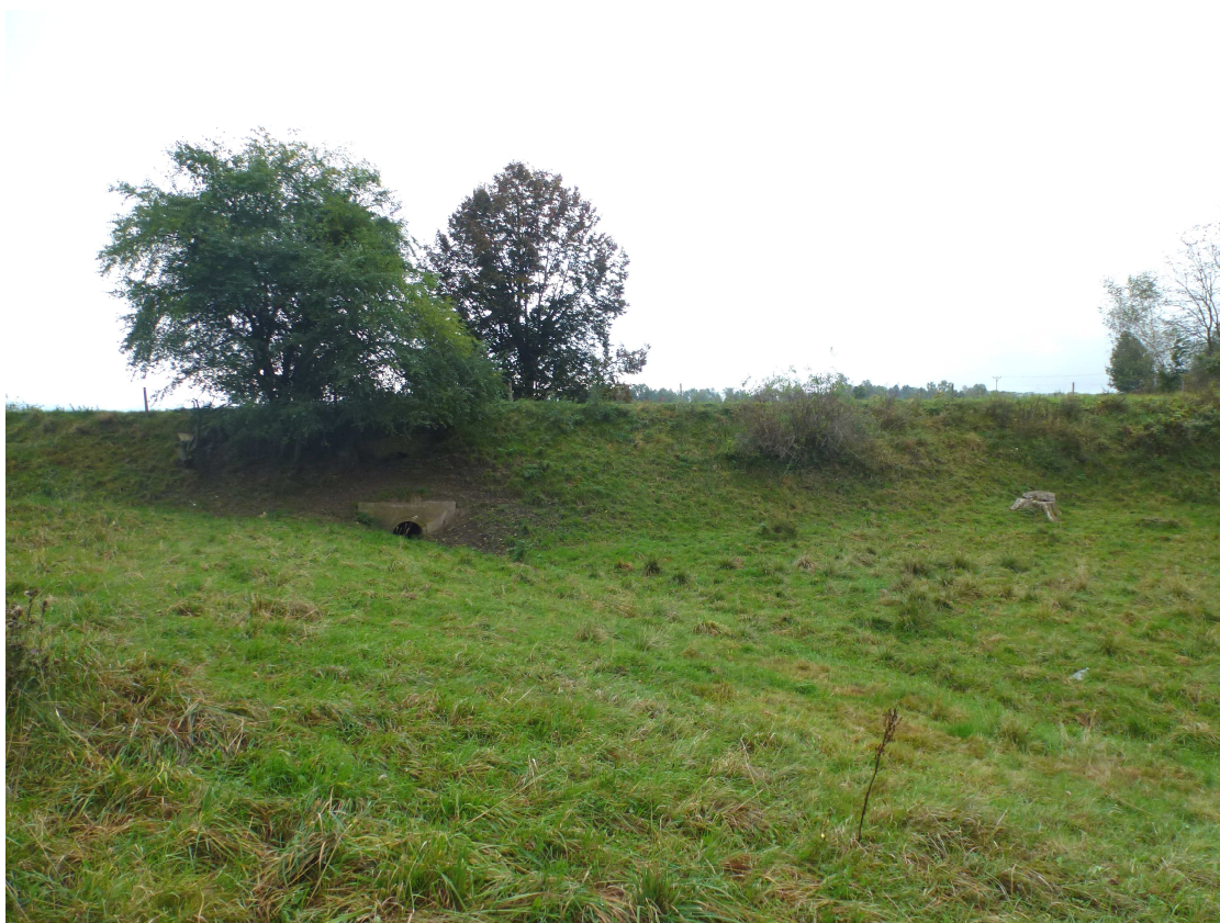
Obr. 13. Propustek pod silnicí Jablonné – Valdov.
