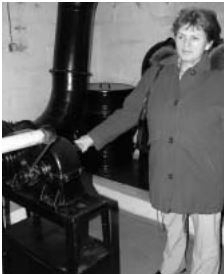
Náhradní zdroj elektrického proudu, který se uvede do chodu ručním otáčením, jak znázorňuje M. Tauchmanová
