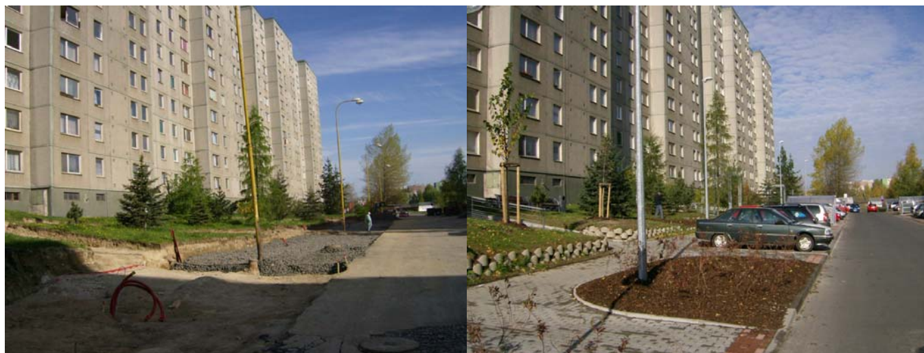
Obr. č.2 Regenerace sídliště Rochlice – II. etapa – Ježkova ulice (v průběhu a po ukončení revitalizace)
