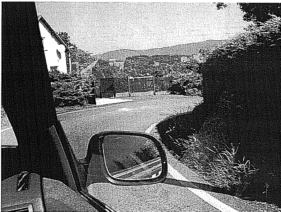
Nedostatečné rozhledové poměry a nezpevněné krajnice
