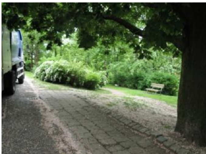
Stávající betonový chodník k rekonstrukci
