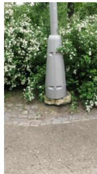
Nevhodná instalace odpadkového koše a sloupu VO
