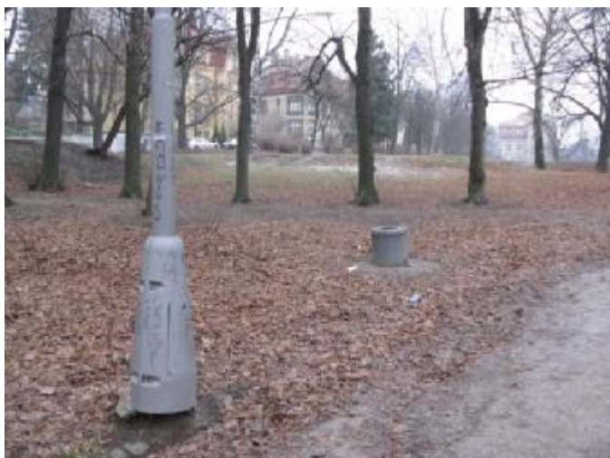
Nevhodná instalace odpadkového koše a sloupu VO
