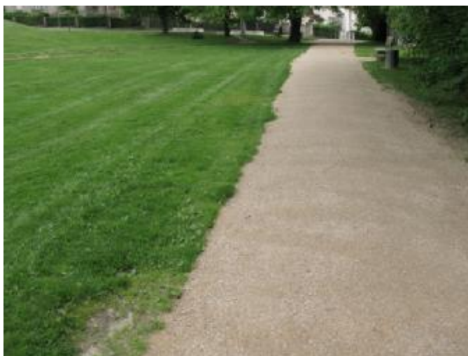
Stávající perková komunikace bez boční stabilizace
