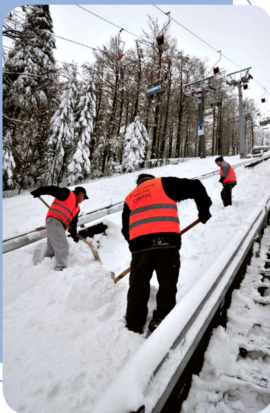
Pracovníci společnosti se podílejí i na úklidu sněhu na doskočišti můstků na Ještědu
