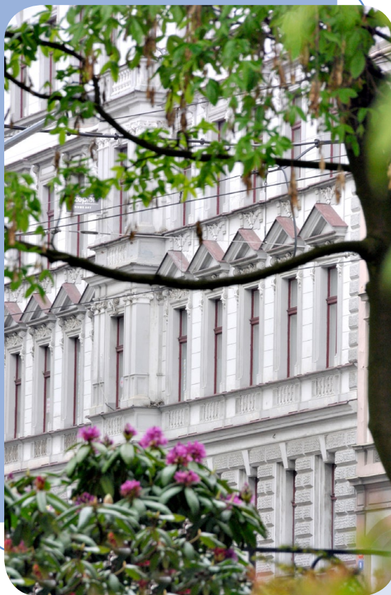
Sídlo Komunitního střediska Kontakt Liberec v Palachově ulici
