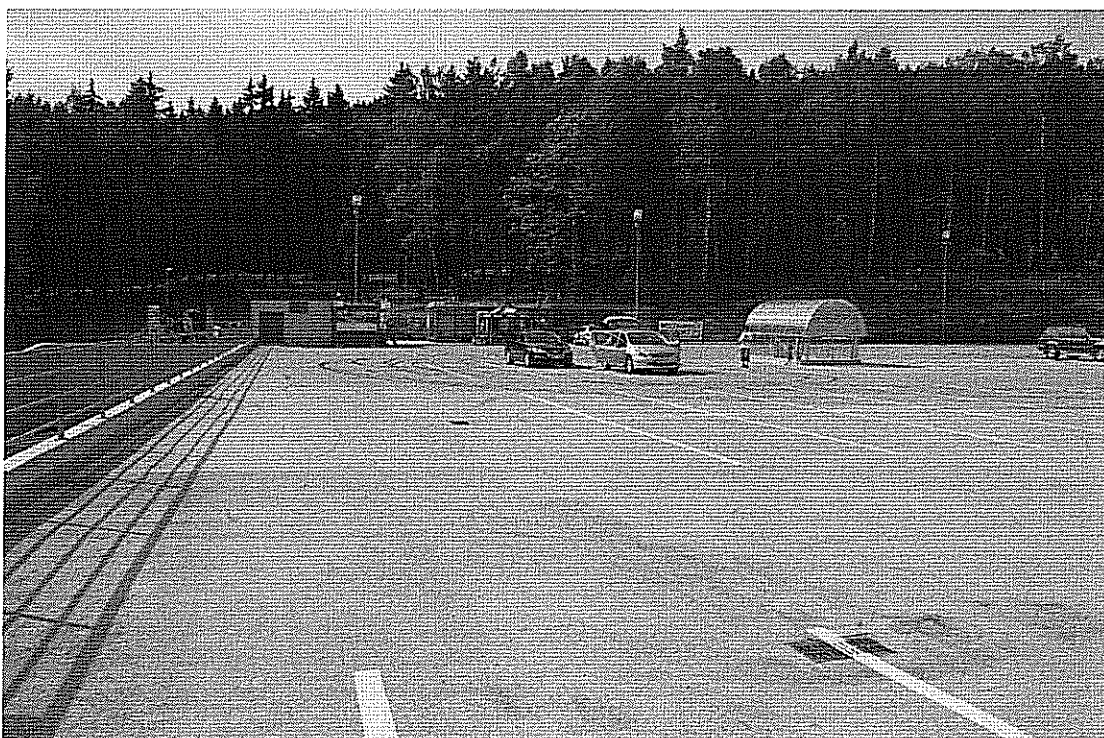
Pohled na centrální parkoviště areálu Ještěd – pokladna a půjčovna lyžařského vybavení
