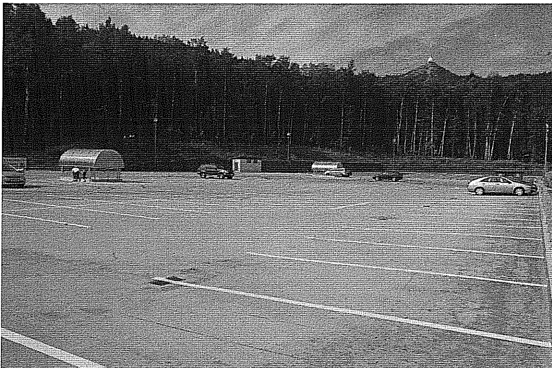
Pohled na centrální parkoviště areálu Ještěd
