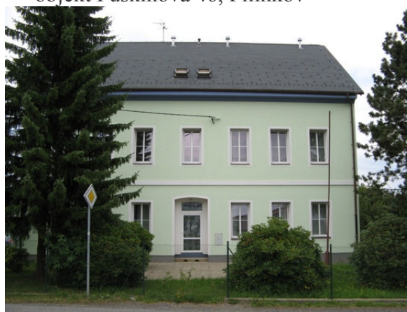
objekt Puškinova 46, Pilínkov
