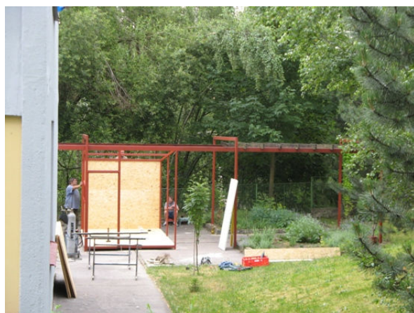
stavba přístřešku na dřevo
