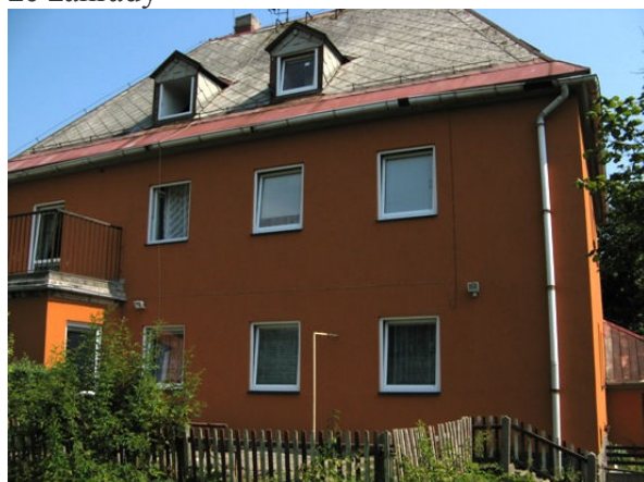
objekt Uhlířská 424, Liberec 11- pohled ze zahrady
