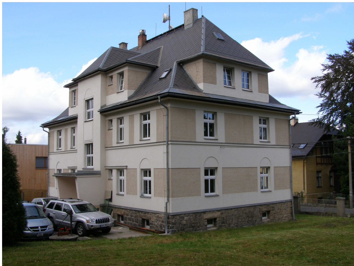
Budova č. p. 73, ul. Kašparova, Liberec 25
