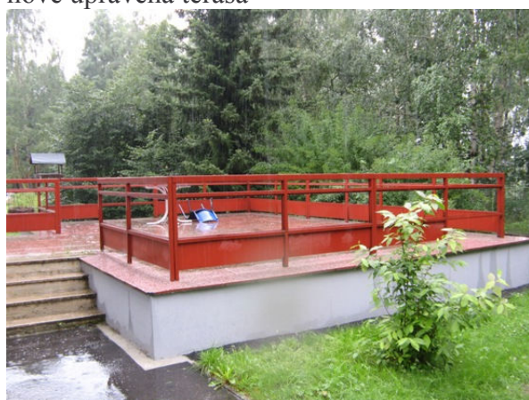
nově upravená terasa
