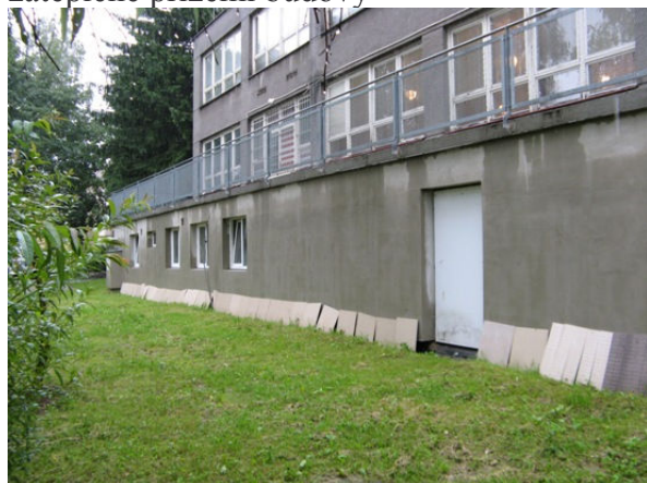
zateplené přízemí budovy
