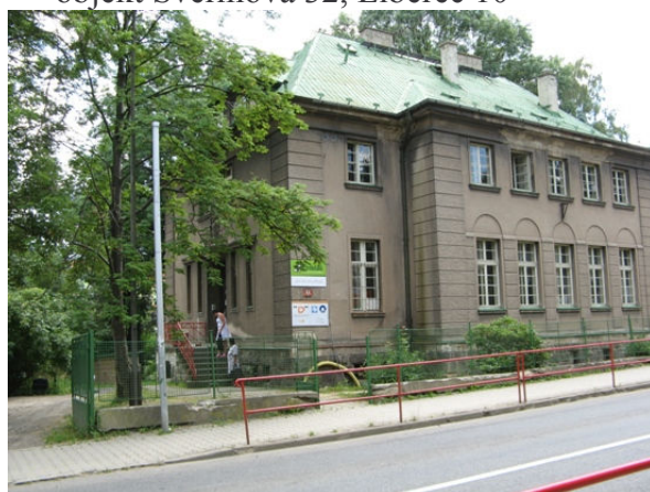
objekt Švermova 32, Liberec 10
