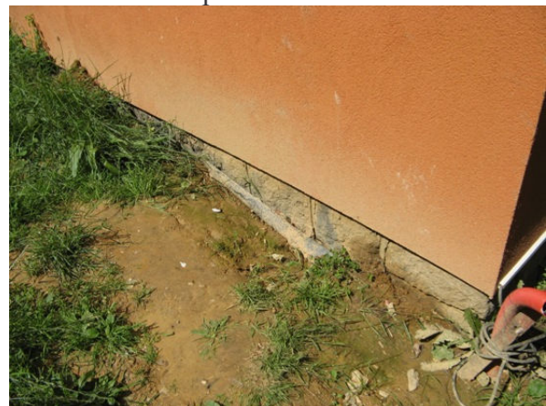
nová izolace proti vodě
