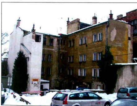
Dvorní, severovýchodní fasáda
