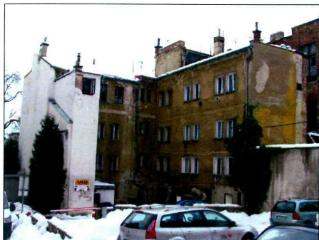
Dvorní, severovýchodní fasáda
