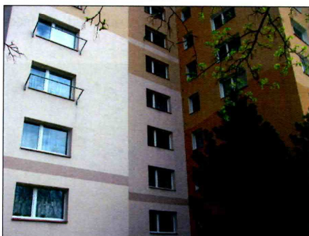
Pohled na okna ve 4.NP
