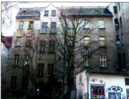
Pohled na zadní průčelí domu čp.74 z ulice Kavčí
