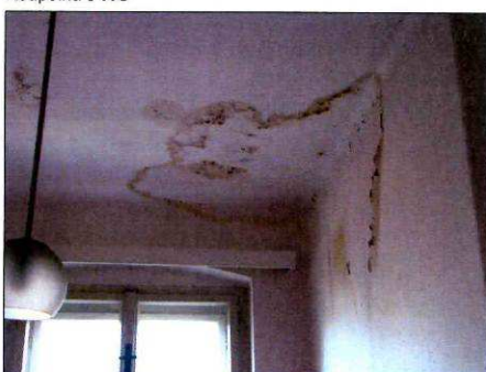
Stopy zatékání
