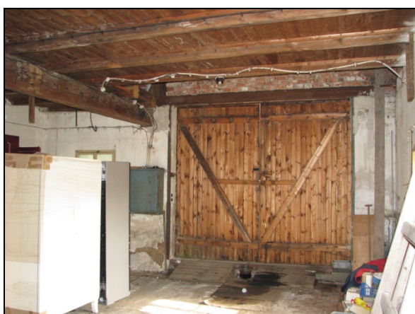
Vrata v jižní stěně
