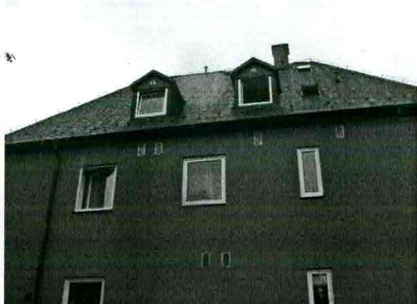
nová střecha na objektu
