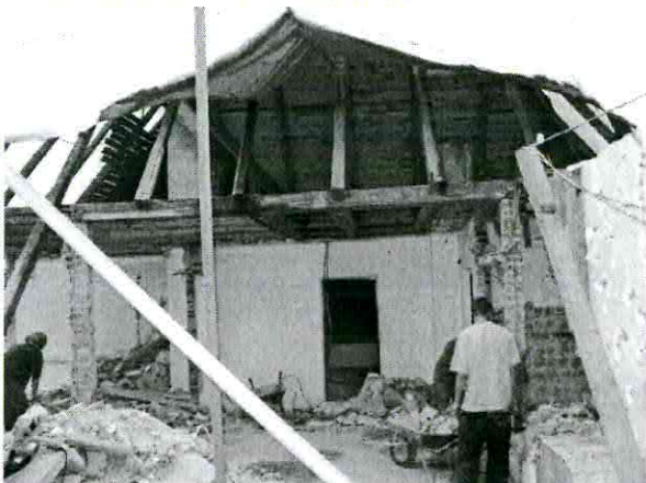
Vlčí vrch 323 - rekonstrukce
