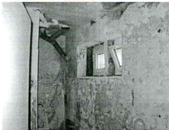
nová okna v suterénu
