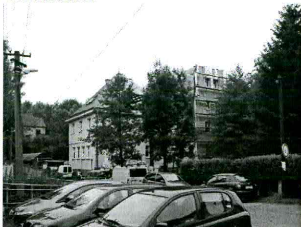
Vlčí vrch 323- domov pro mentálně postižené - rekonstrukce
