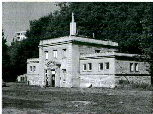
objekt Pastýřská 645, Liberec 1
