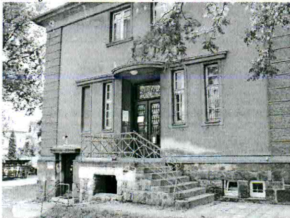
objekt Švermova 32, Liberec 10
