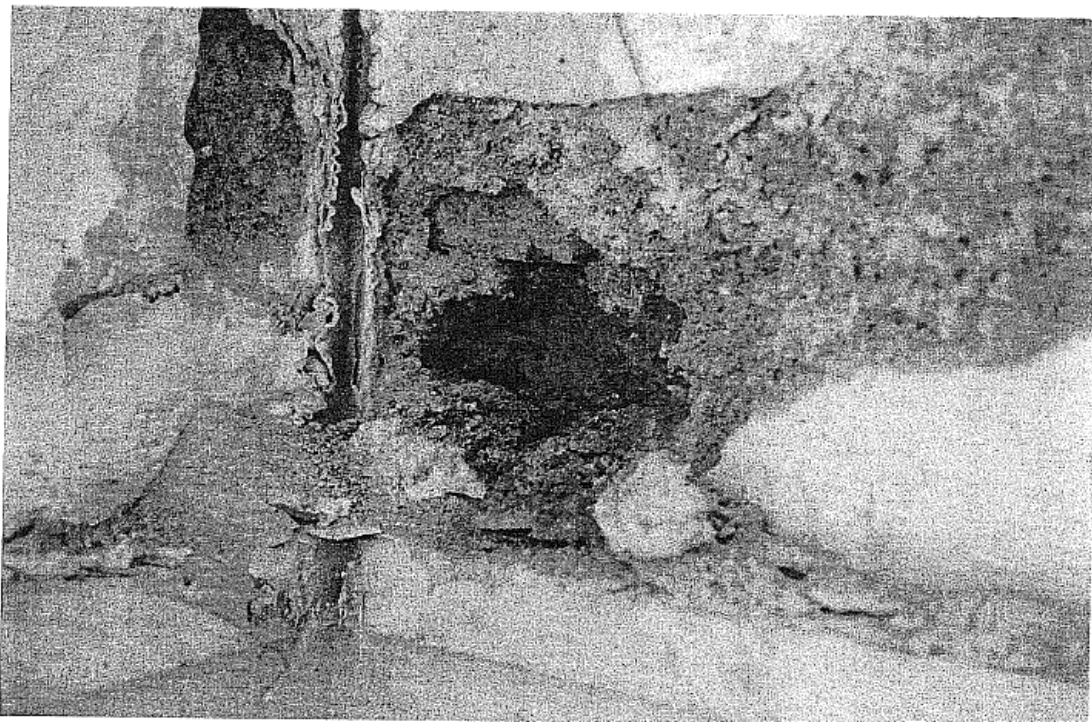
Degradace zdiva na vnitřní straně rohu. Cihelné zdivo okolo rohu dožilé.
