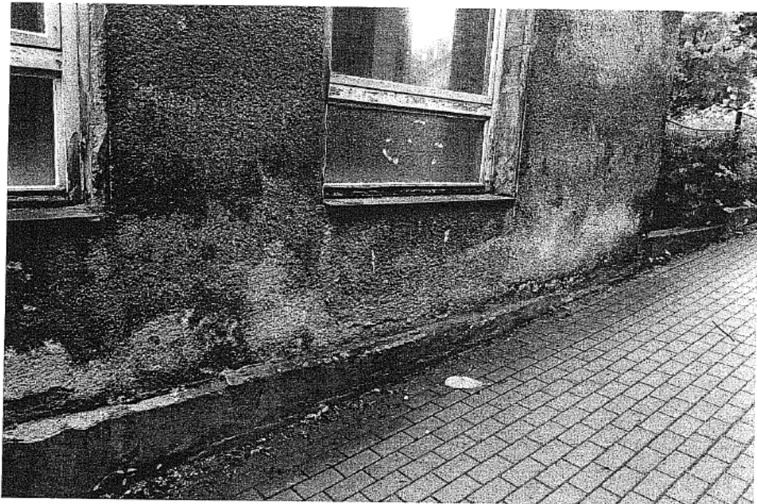
Vzlínání vody na rohu objektu, odpadávající sokl.
