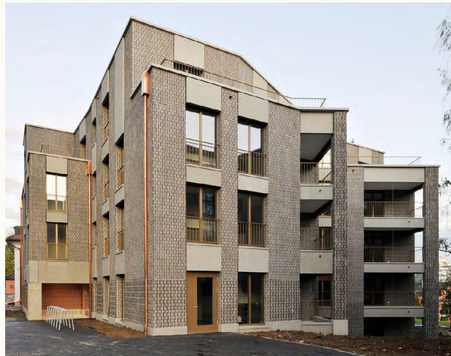
Příklad řešení částečně ustupujícího podlaží s terasami
