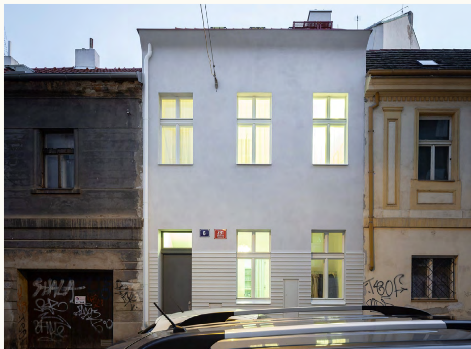
rekonstrukce bytového domu, Vršovice, Praha, BY architects, 2016
