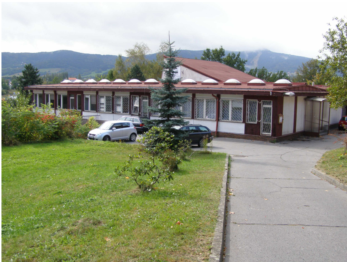
Budova občanského vybavení bez č. p. na pozemku p. č. 911/3
