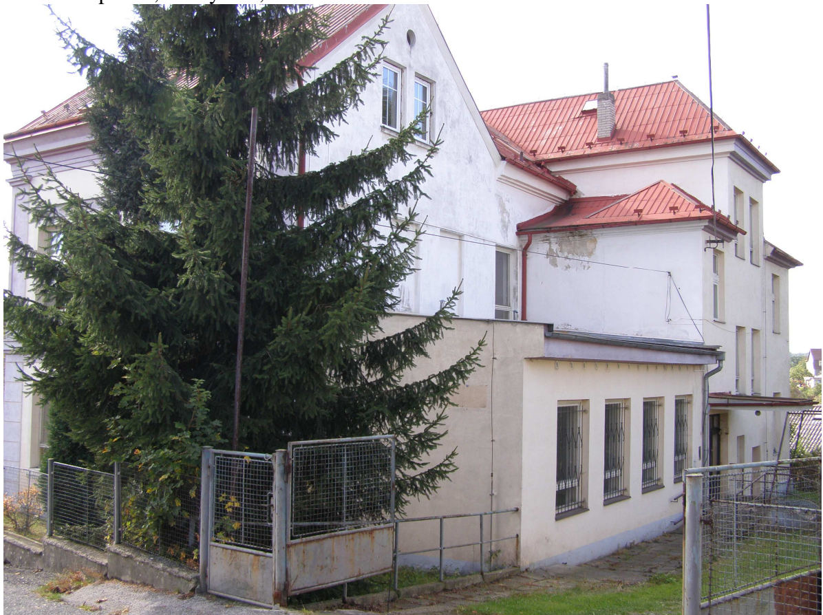
Budova č. p. 198, ul. Výletní, Liberec 32
