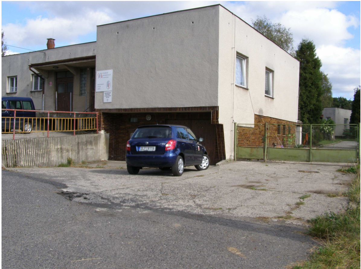
Budova č. p. 152, ul. Výletní, Liberec 32
