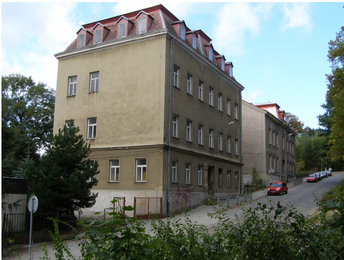
Budova č. p 151 a č. p. 101 ul, Na Žižkově
