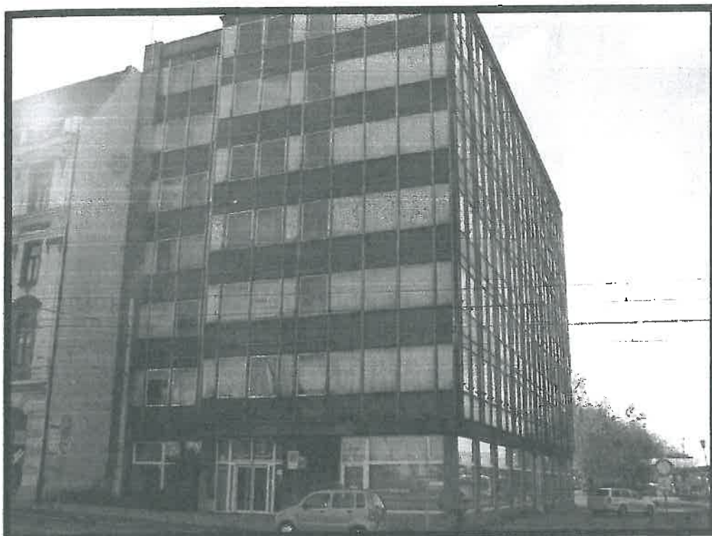
Pohled na objekt - přední strana a vstup do objektu
