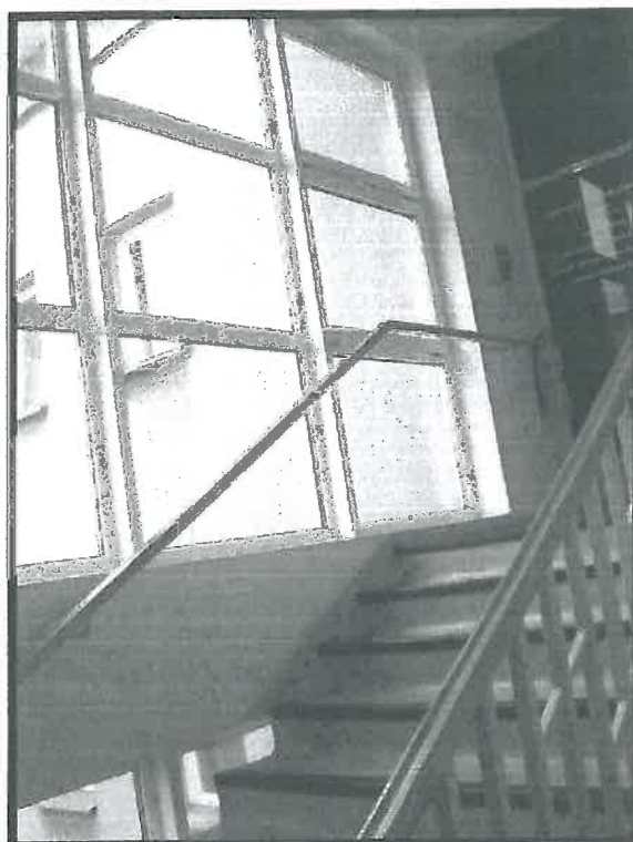
Pohled na schodiště objektu
