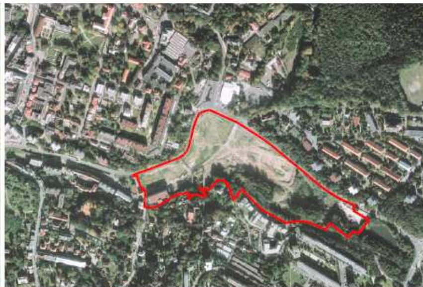
AREÁL PO DEMOLICÍ (SOUČASNÝ STAV) AREA AFTER DEMOLITION (ACTUAL VIEW)
