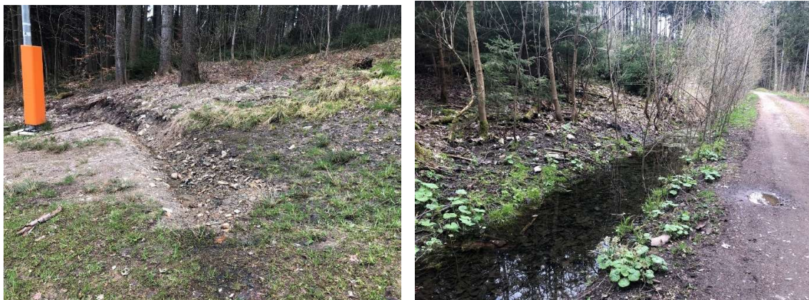
Obrázek č. 20 Odvodňovací příkopy při okraji sjezdové trati a zavodněné příkopy po jarním tání (4/2023)
