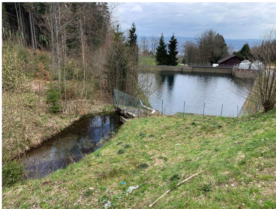
přítok Slunného potoka do nádrže Bucharka (plocha 0,3 ha, retenční objem 12,6 tis. m 3 )
