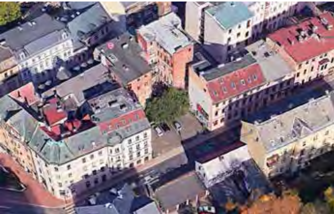
Proluka v souvislé zástavbě, ul. Husova (zdroj: Google Maps, 2025)
