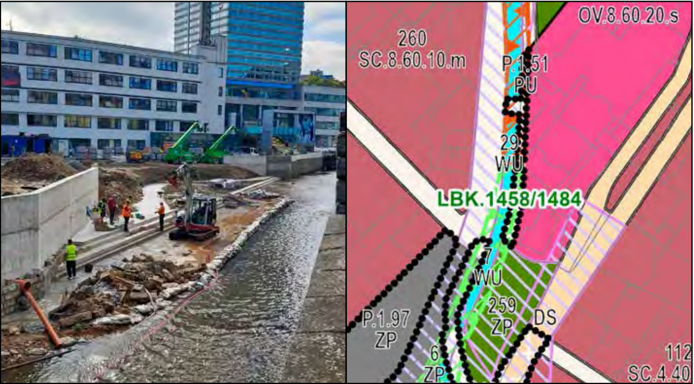
Částečně využitá plocha P.1.51 PU v ulici U Jezu - stavba náplavky. (zdroj: novinky.cz, 9. 9. 2025)
