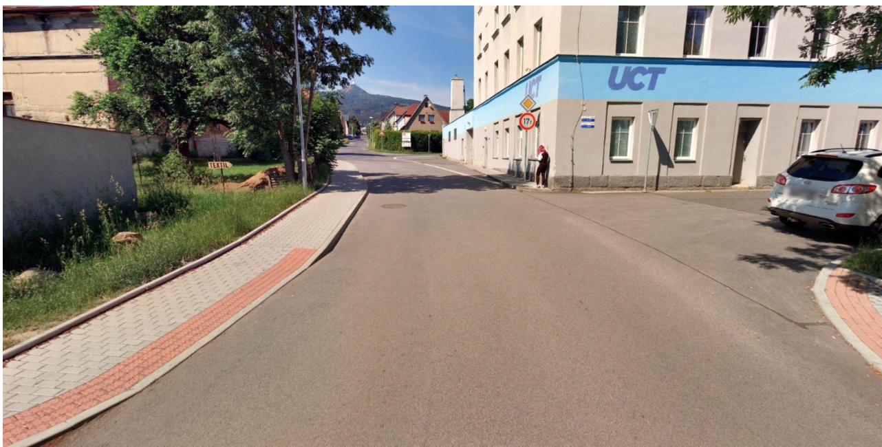
Ulice Strakonická v prostoru napojení ulice V Horkách, váhové omezení 17t ve vazbě na mostní objekt a zakrytí vodoteče (prostor za areálem na foto)
