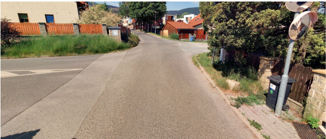
Ulice Strakonická v místě napojení ulice Březnické – vlevo
