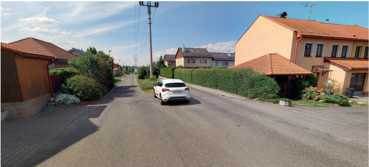
Ulice Březnická v úseku směrově rozděleném před napojením na ulici Strakonickou
