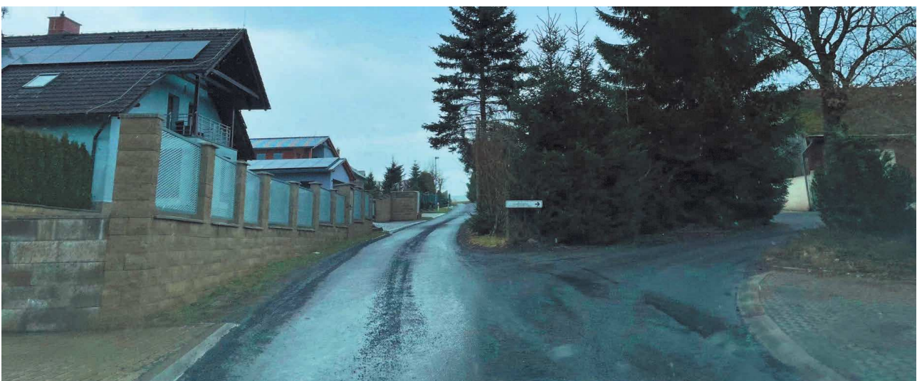
Napojení ulice Přímé se zjištěním minimálního až nulového rozhledu výjezdu z Přímé na Švestkovou (i při zastavení vozidla nutný vjezd do profilu průjezdu Švestkové – jedná se o zjištěnou provozní závadu s možností zlepšení například osazení, dopravního zrcadla zlepšujícího rozhled vpravo z Přímé)
