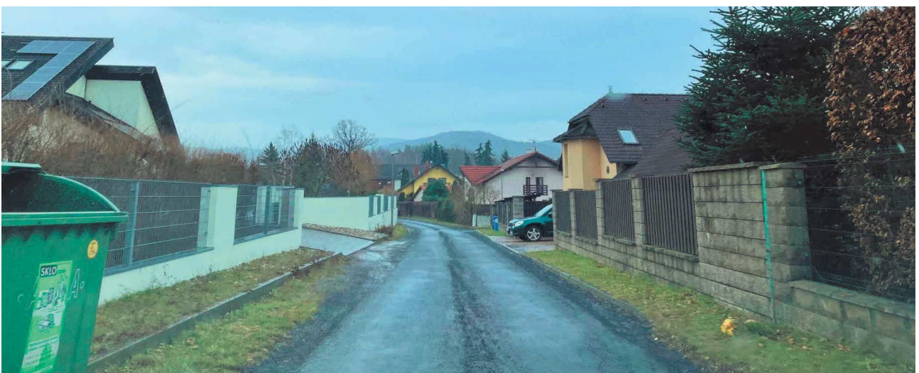
Dohledové foto od napojení z ulice Rybízové (prvního napojení od napojení na Hejnickou) – provedení napojení RD / vjezdů a zobrazení celkové volné šířky uličního prostoru (5-6m)
