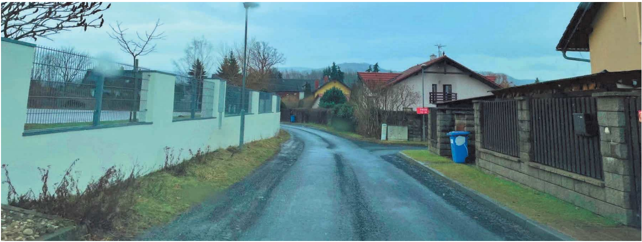
Druhé napojení ulice Rybízové ve směru od Hejnické – rozšíření v místě napojení možné uvažovat jako výhybnu, dohledové vzdálenosti vyhovující, dostatečné
