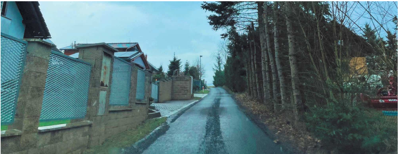
Stav ulice Švestkové od napojení ulice Přímé s napojením okolních pozemků – z pohledu profilu komunikace dostatečná šířka zpevněného pásu se zúženou krajnicí po levé straně dle směru foto, dobrá dohlednost
