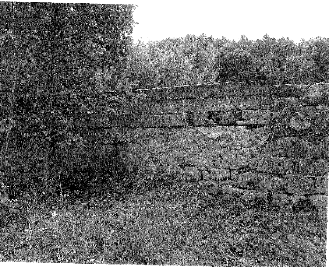
2 Nadezdívka ze struskobetonových tvárnic
