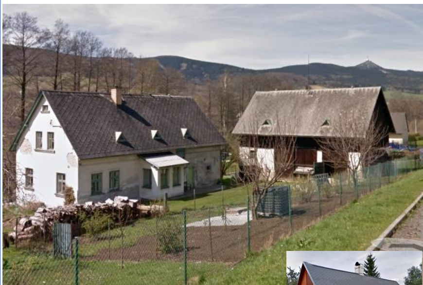
3. Původní zástavba Minkovic, zděný dům se stodolou Buková ul. čp. 72
