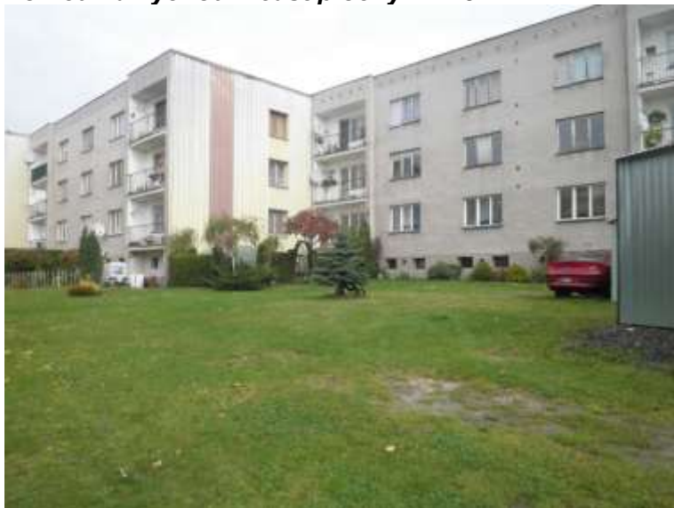
Pohled na východní část plochy 2Z 164.
