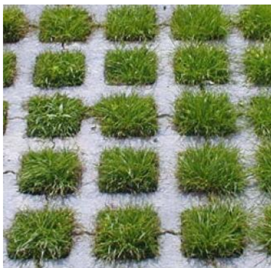
Obr. zatravnovací dlažba
