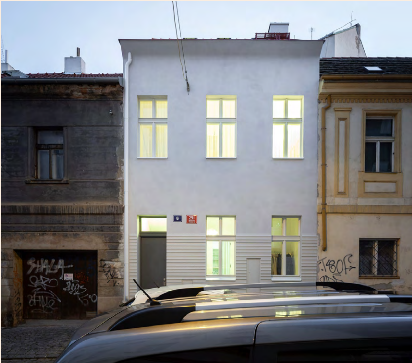
rekonstrukce bytového domu, Vršovice, Praha BY architects, 2016
