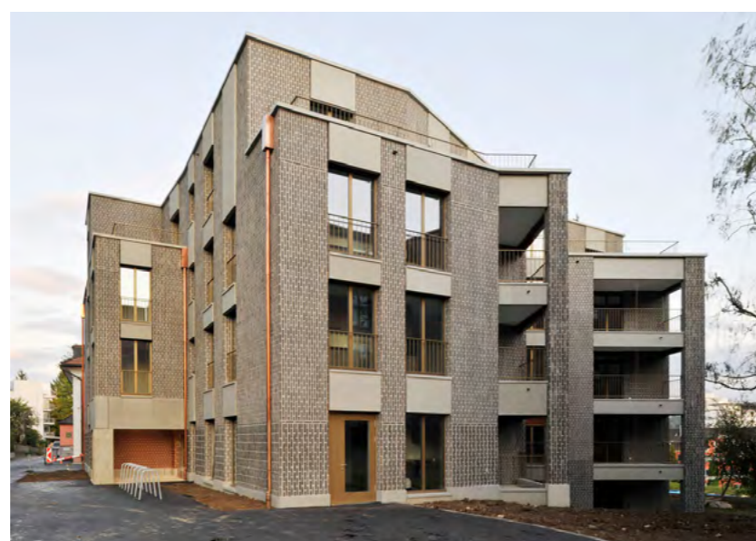
příklad řešení částečně ustupujícího podlaží s terasami Seebach suburban housing, Zurich, 2019 Sergison Bates architects
